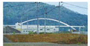
平成31年春に開通予定の気仙沼大島大橋(愛称:鶴亀大橋)
